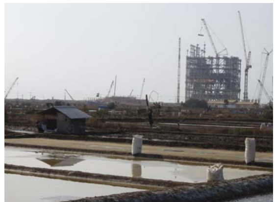
写真：1 号機の隣接地で進められている 2 号機の建設工事。住民の生活の糧である多くの塩田が奪われた。（FoE Japan。2019 年 7 月）
