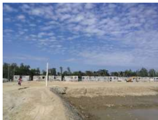
建設中の移転住民向け代替家屋
