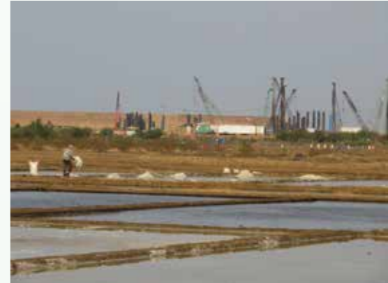
2号機の建設作業のすぐ側で塩づくりを続ける塩田農家
