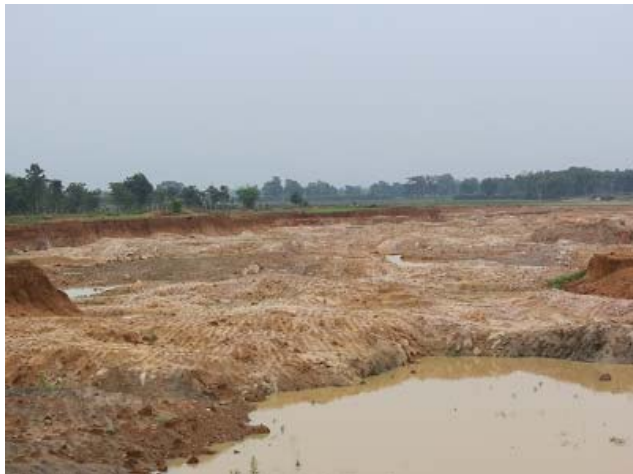
写真 1：発破作業の実施後の様子（2015 年 7 月）
