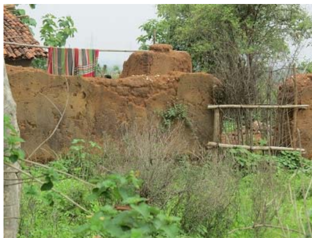
写真 2：発破作業で破損した土壁（2015 年 7 月）
