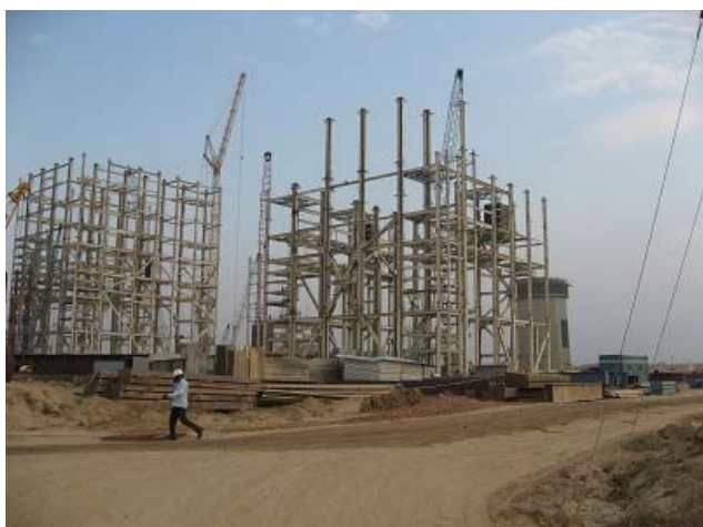
写真 5：建設中の発電所の様子
