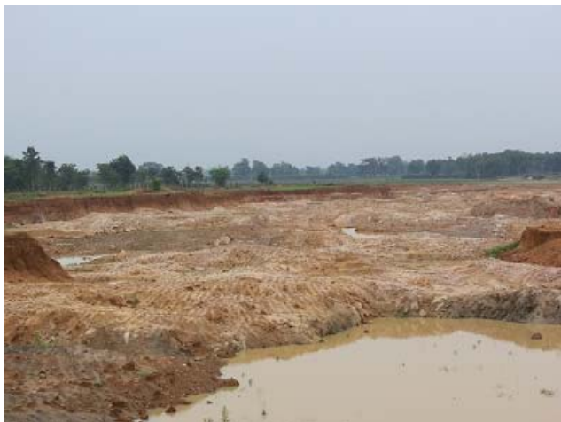
写真 1：発破作業の実施後の様子（2015 年 7 月）
