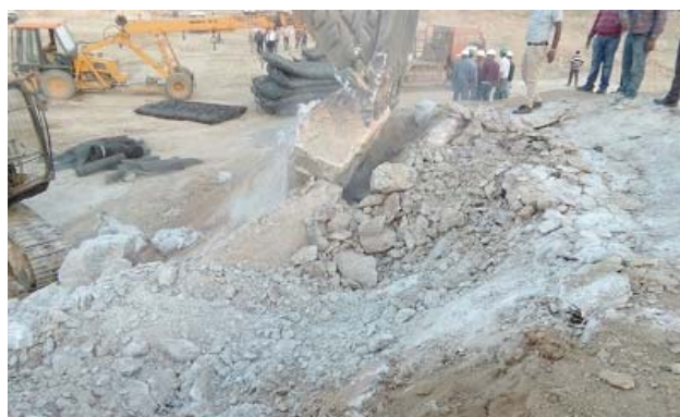
写真 4：発破作業の様子（事後）（2016 年 1 月）
