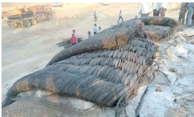
写真 3：発破作業の様子（事前）（2016 年 1 月）
