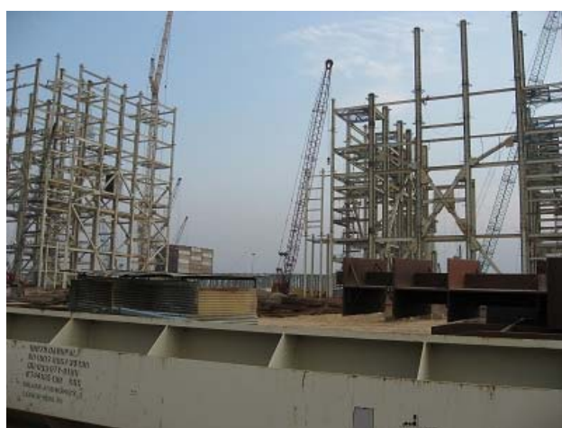
写真 6：建設中の発電所の様子
